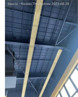
Figure 8.5 – Dalles préfabriquées et structure d'acier
