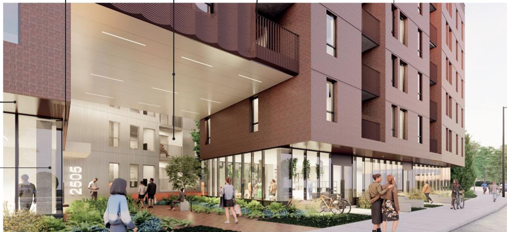
Soffite métallique, couleur agencée à la brique telle que brun argile de Duchesne
