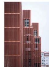
FAÇADE MÉTALLIQUE APARTHEMENT DE ROSSIGNOL SECURITY (Vareuse, Poitou)
